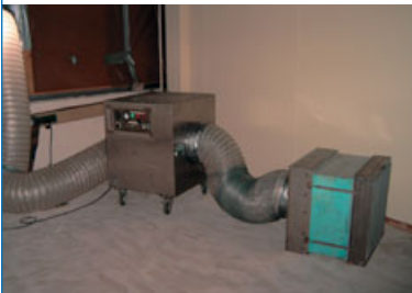
Bild 9: Technische Entlüftung bei starkem Schimmelpilzbefall
